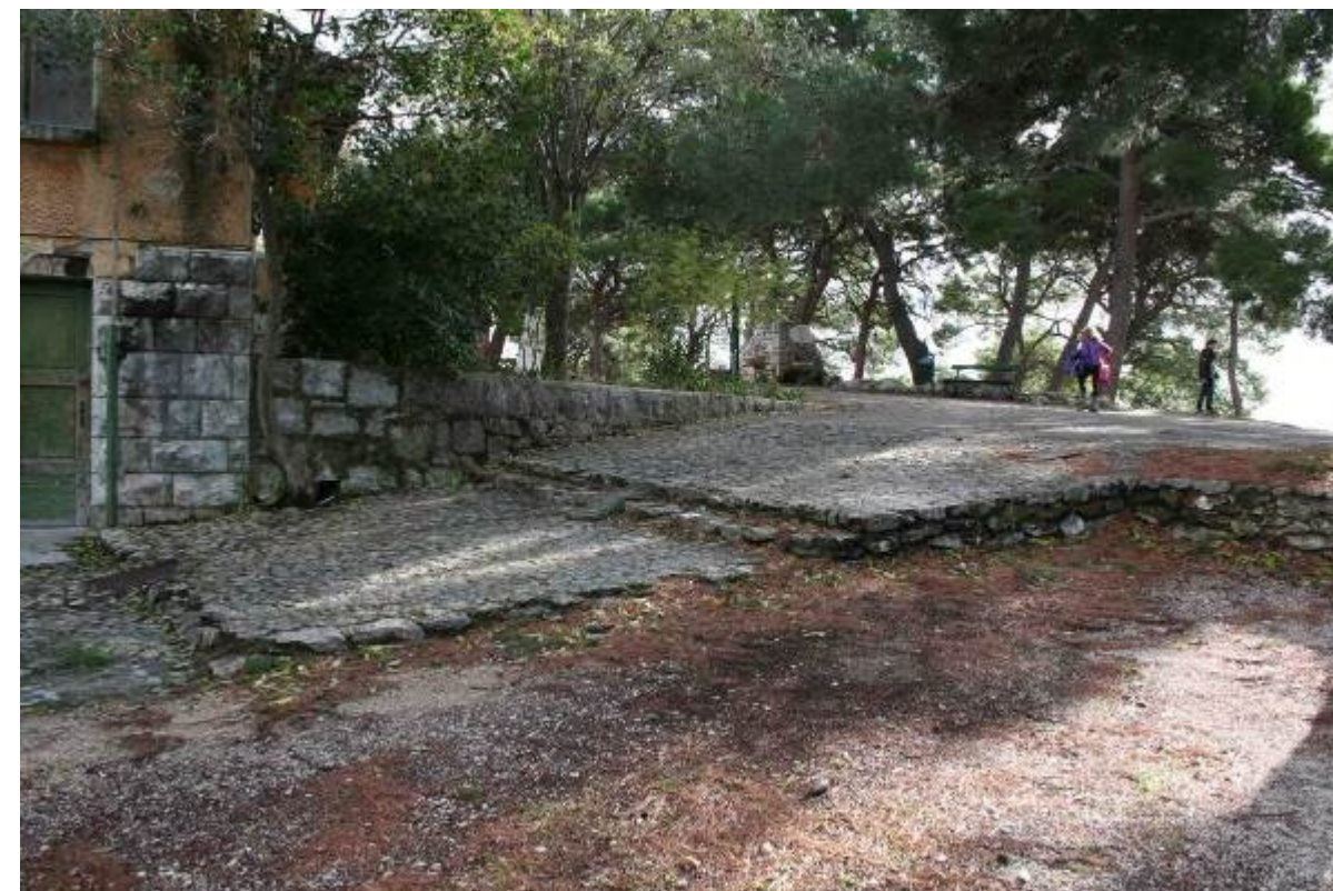
Rampa uz jugozapadni ugao zgrade nekadašnjeg velikog restorana
