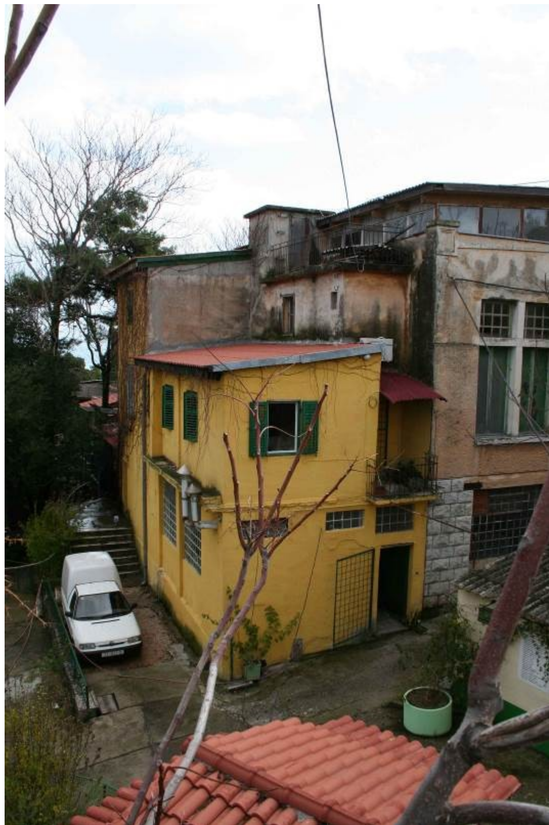
Pogled na sjverozapadni dio nekadašnjeg velikog restorana, kasnije Prirodoslovnog muzeja s naknadnim prigradnjama
