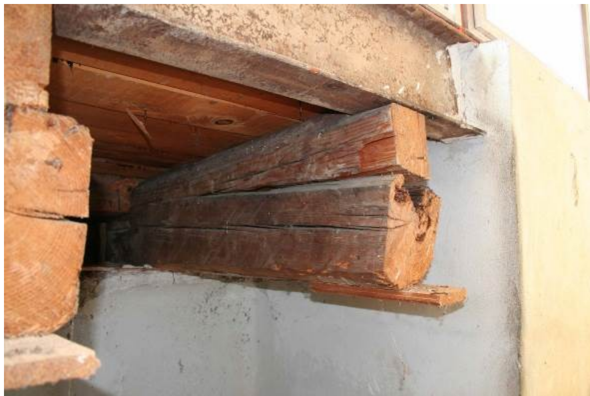
Odsječene krede originalne drvene krovne konstrukcije
