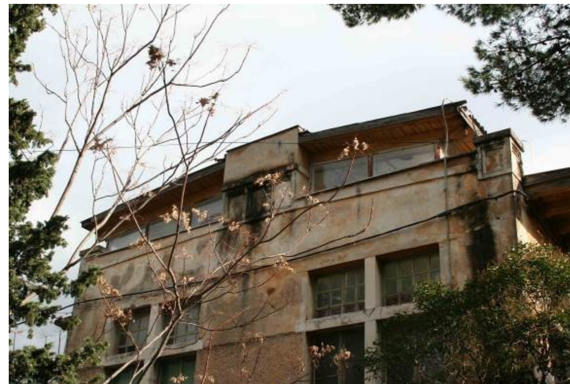
Nadogradnja nad zapadnim pročeljem, današnje stanje
