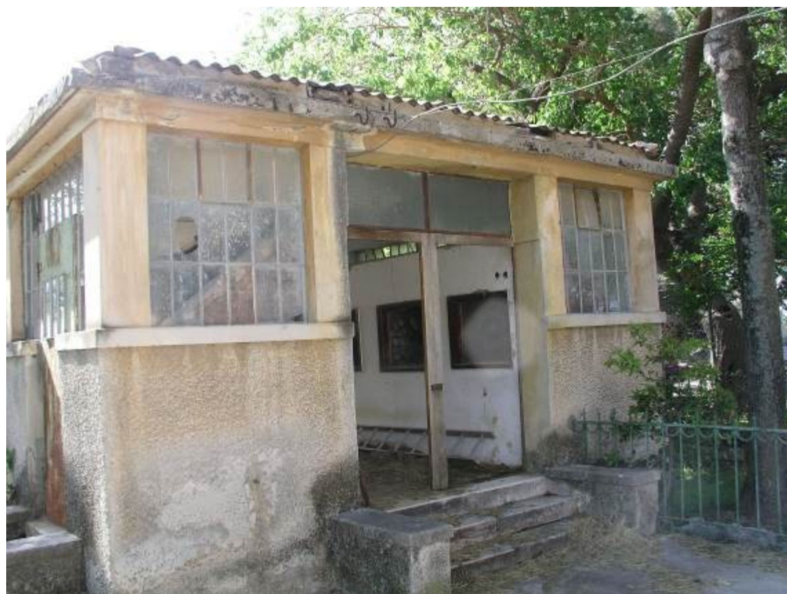
Zgrada akvarija prije rušenja
