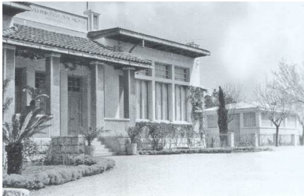
Zgrada Prirodoslovnog muzeja sa zgradom akvarija u pozadini, snimljeno nedugo poslije gradnje akvarija.
