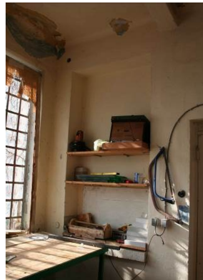
Prozor istočnog pročelja pretvoren u nišu
