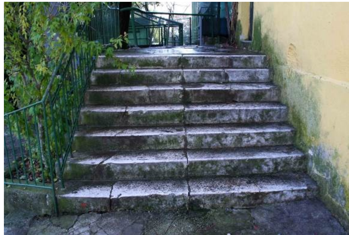
Desni dio stepenica pripadao je vanjskom stubištu koje je vodilo na 1. kat
