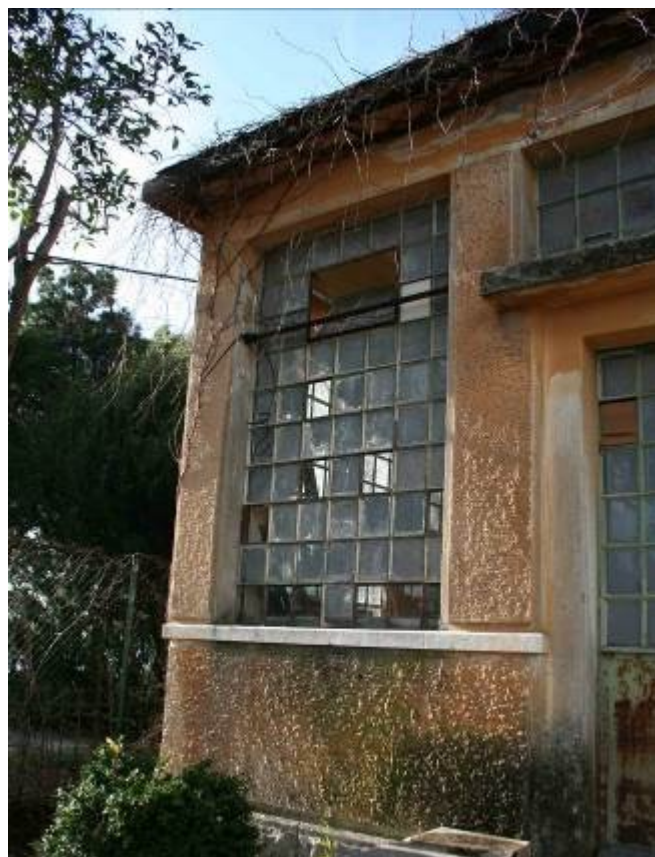
Detalj žbuke i ostakljenja
