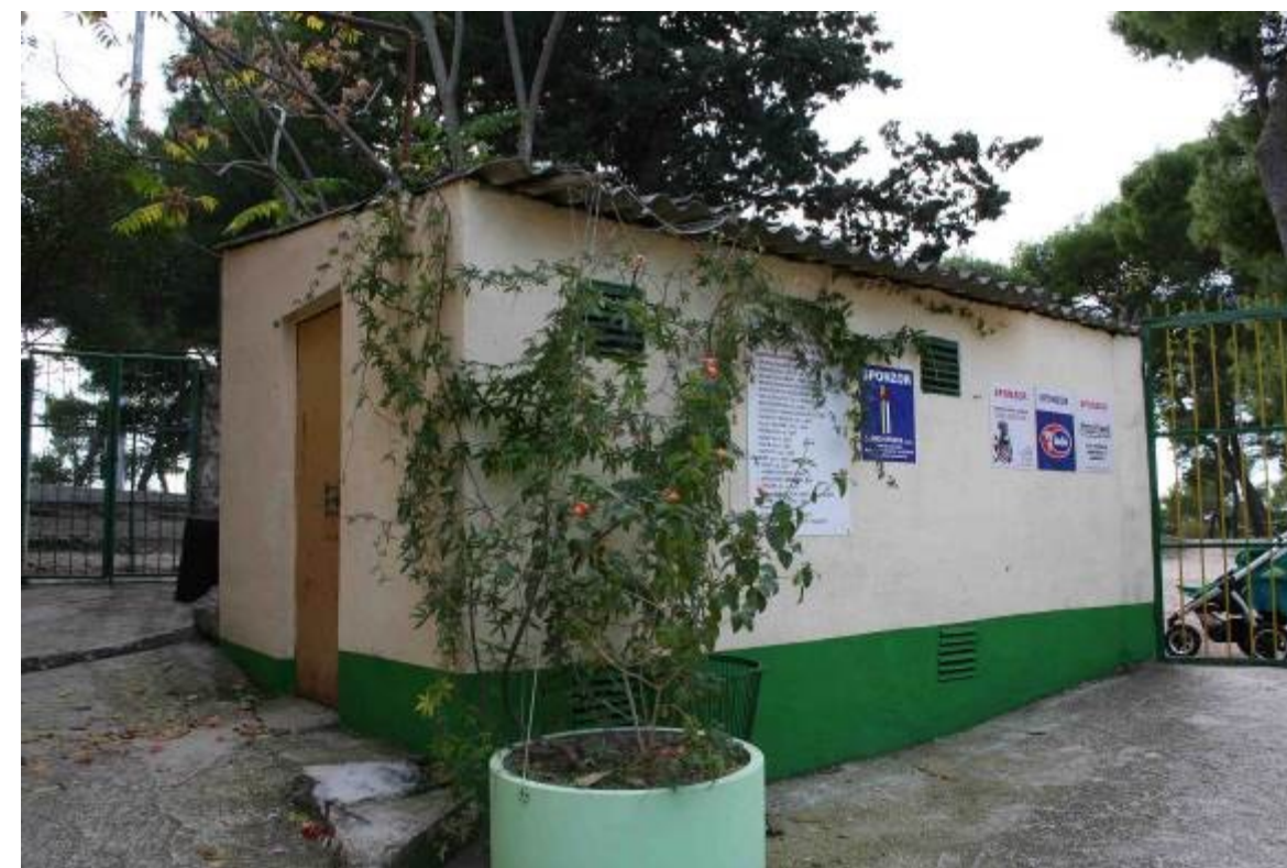
Spremište plina centralnog grijanja izgrađena 70-tih godina
