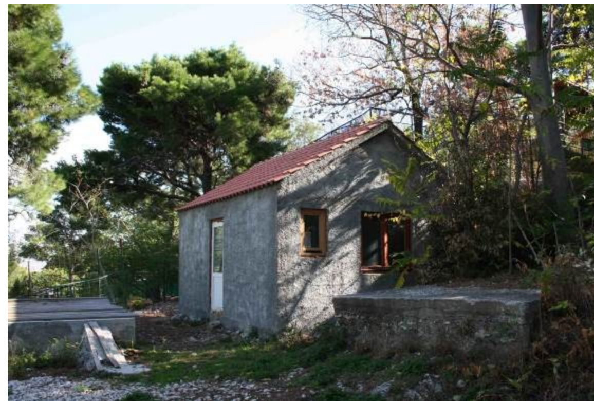
Recentno izgrađena kućica sjevernije od javnog WC-a
