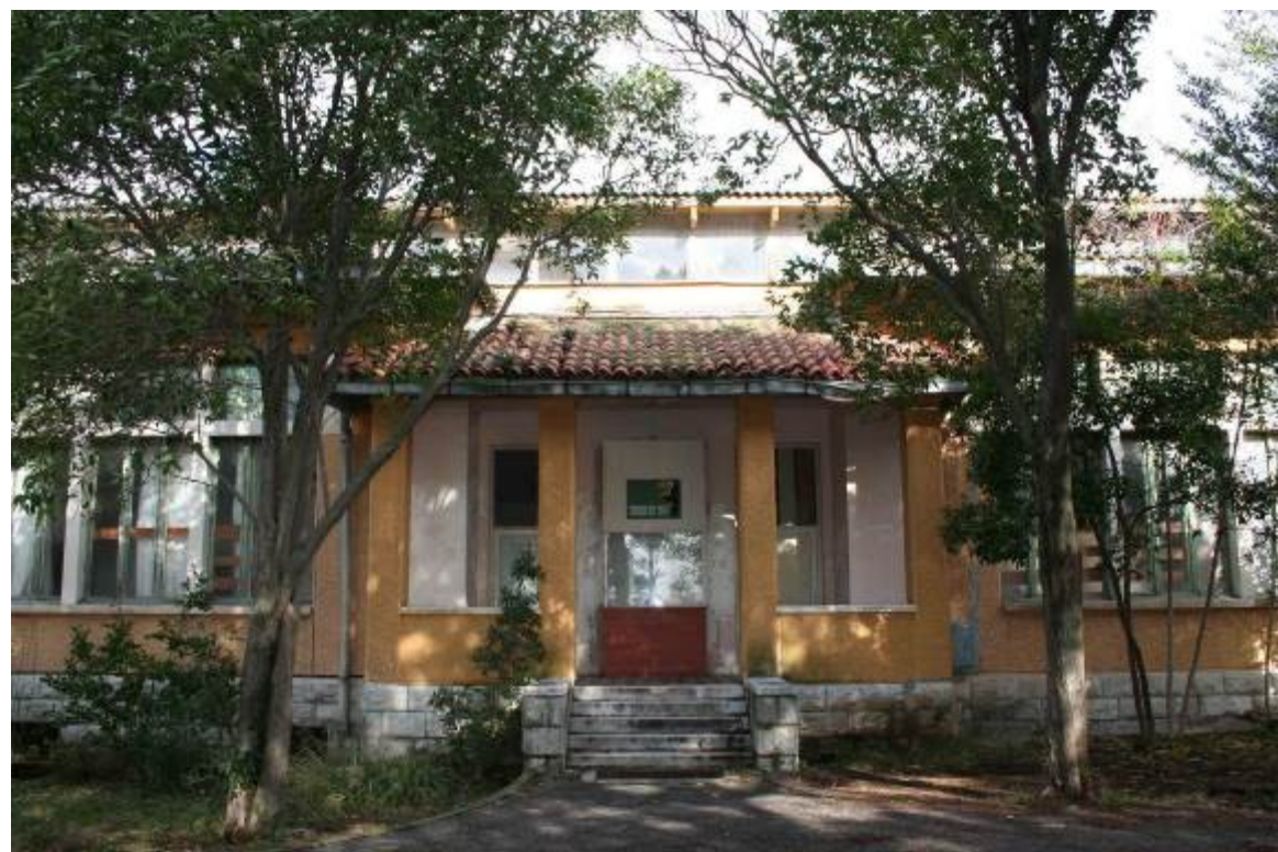
Glavni ulaz u zgradu, središnji dio južnog pročelja bez izvorne atike
