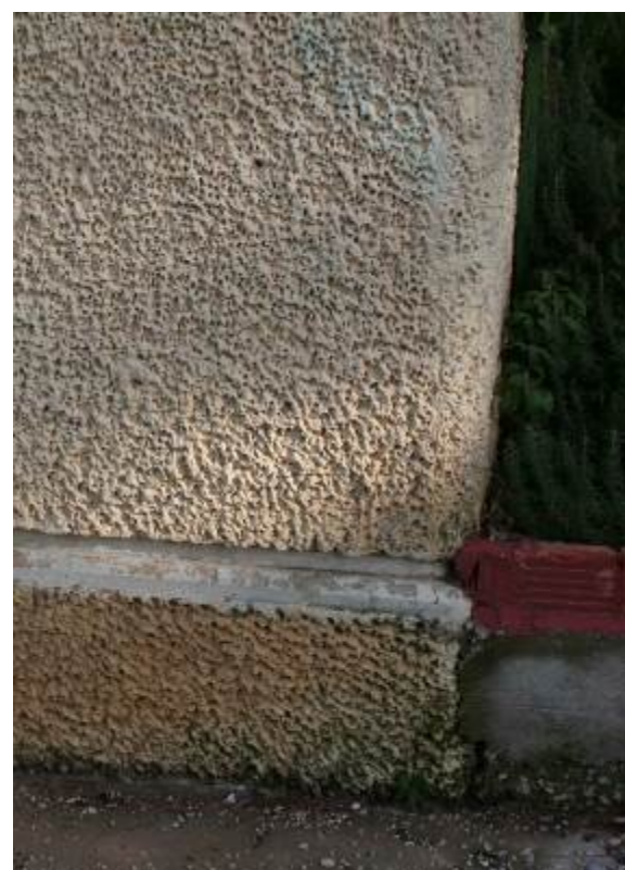
Gruba reljefna žbuka i profilacija sokla
