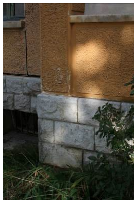
Spoj kamenog sokla i zida verande
