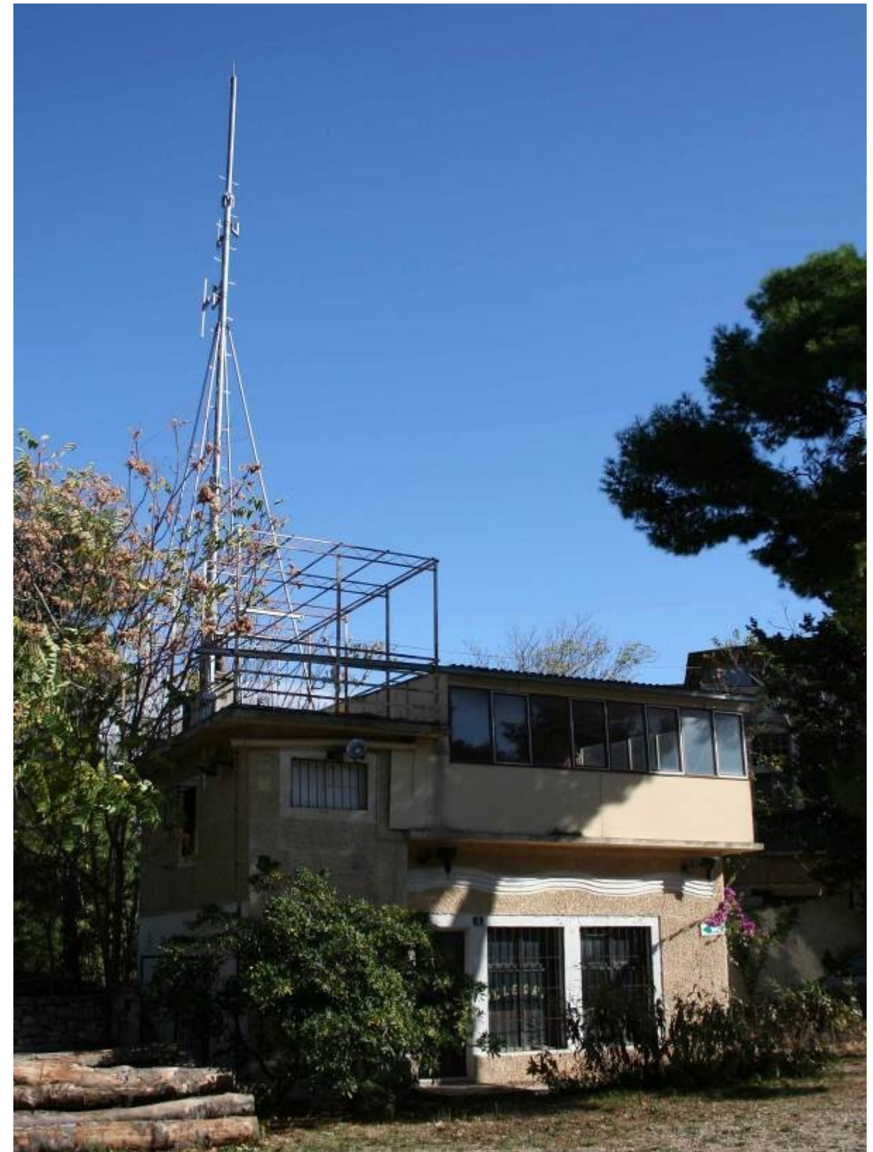
Antena na sjevernom volumenom malog secesijskog restorana
