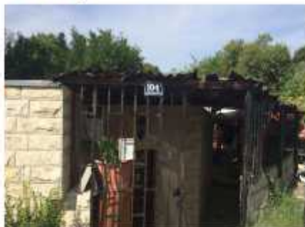
Istočno i sjeverno pročelje
