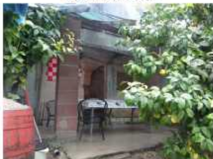
Zapadno pročelje; sjeverni dio građevine (adresa Meštrovićevo šetalište 120 A)
