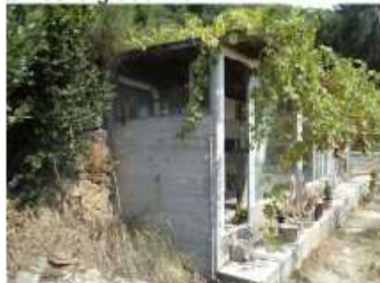
Zapadno pročelje; pogled jugozapad
