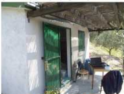
Južno pročelje; pogled jugozapad
