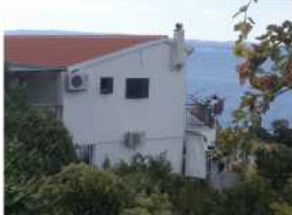
Zapadno pročelje; pogled sjeverozapad
