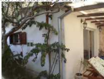
Zapadno pročelje; pogled jugozapad
