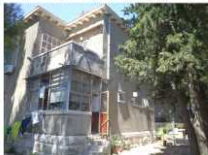
Istočno pročelje; pogled jugoistok
