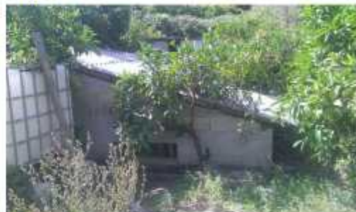
Zapadno pročelje Objekt B
