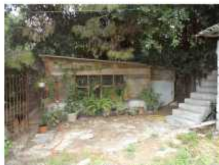
Pomoćna građevina 2; pogled istok
