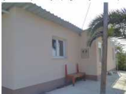
Južno pročelje; pogled jugozapad
