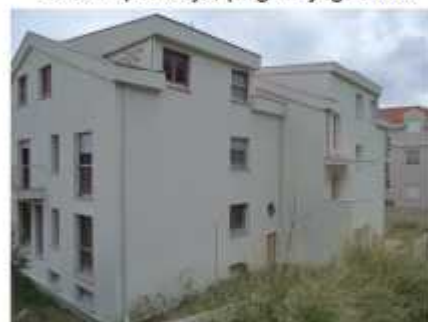
Sjeverno pročelje; pogled sjeveroistok
