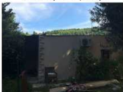
Južno pročelje; pogled jugoistok
