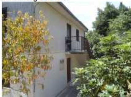
Sjeverno pročelje; pogled sjeveroistok
