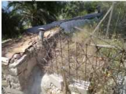
Sjeverno pročelje; pogled sjeveroistok
