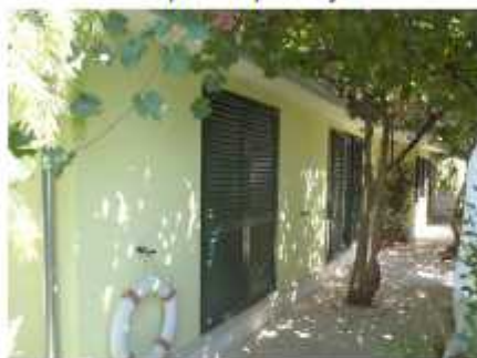
Južno pročelje; pogled jugozapad
