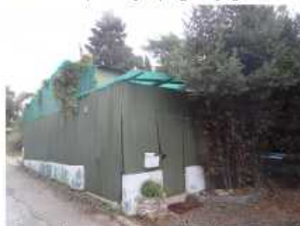
Zapadno pročelje; pogled jugozapad
