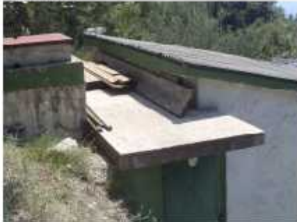
Sjeverno pročelje; pogled sjeverozapad
