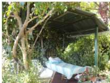
Metalna nastrešnica; pogled jugoistok
