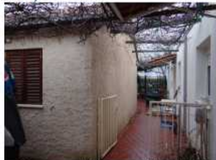
Istočno pročelje; pogled jugoistok
