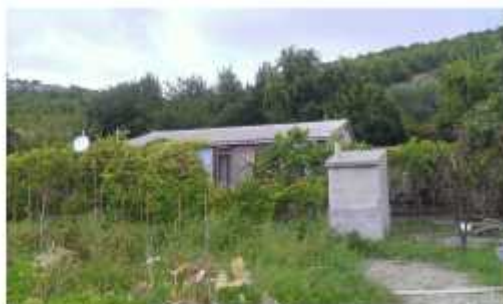
Južno pročelje; pogled jugoistok
