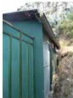
Istočno pročelje; pogled jugoistok
