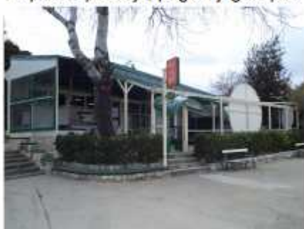
Južno pročelje; pogled jugozapad
