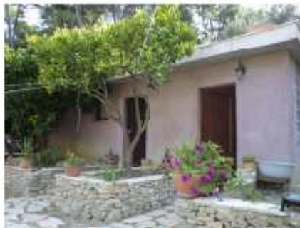
Zapadno pročelje; pogled jugozapad
