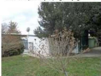
Sjeverno pročelje; pogled sjeveroistok
