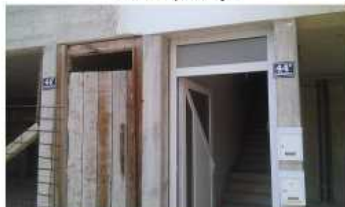
Segment ulaza; južno pročelje
