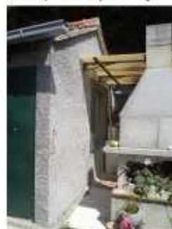
Istočno pročelje; pogled jugoistok
