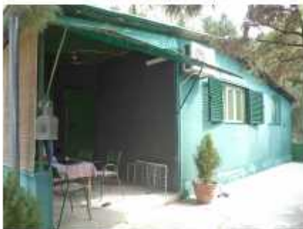
Južno pročelje; pogled jugozapad
