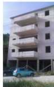
Zpadni dio južnog pročelja
