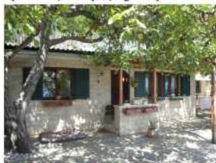
Južno pročelje; pogled jugozapad
