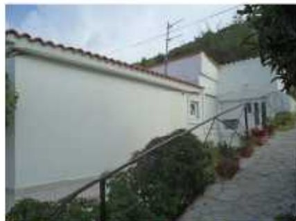
Istočno pročelje; pogled jugoistok
