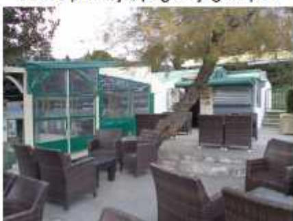
Istočno pročelje; pogled jugoistok
