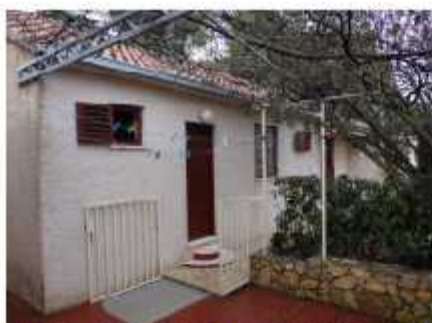
Sjeverno pročelje; pogled sjeveroistok
