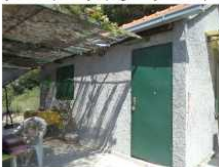
Južno pročelje; pogled jugoistok
