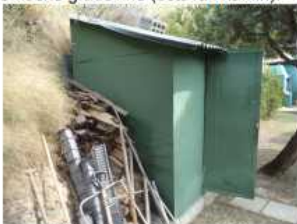
Ostava; zapadno pročelje
