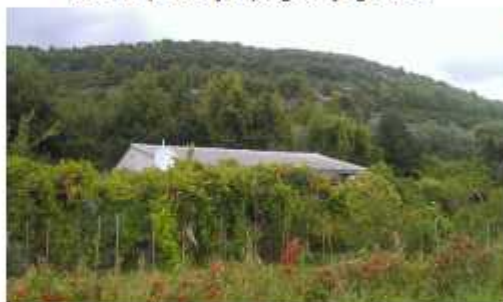
Južno pročelje; pogled jugozapad
