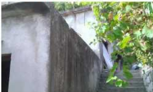
Istočno pročelje; pogled jugoistok
