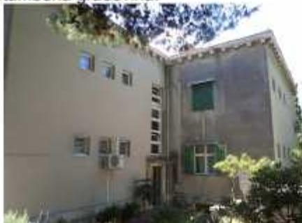
Sjeverno pročelje; pogled sjeveroistok
