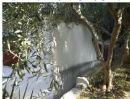
Istočno pročelje; pogled jugoistok
