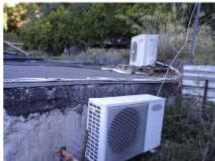
Istočno pročelje; pogled jugoistok
