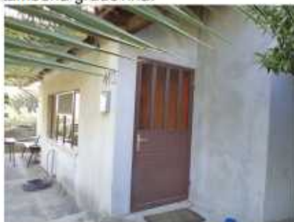
Sjeverno pročelje; pogled sjeverozapad
