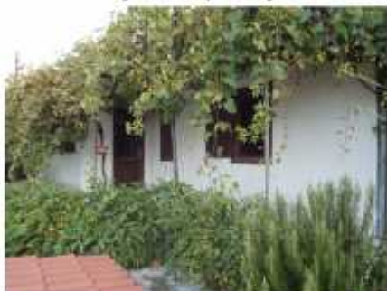
Južno pročelje; pogled jugoistok
