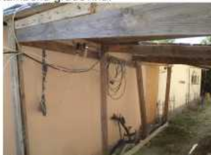
Sjeverno pročelje; pogled sjeveroistok
