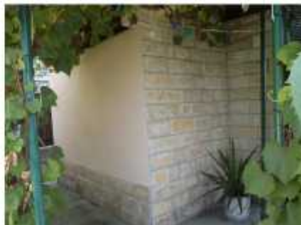
Zapadno pročelje; pogled jugozapad
