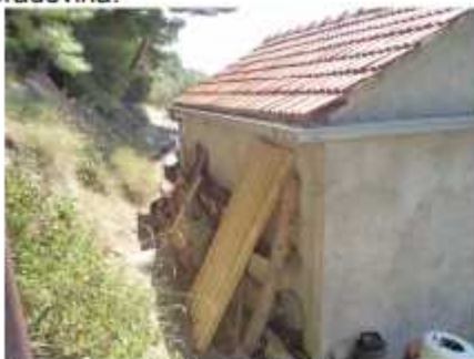
Sjeverno pročelje; pogled sjeverozapad
