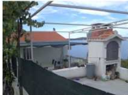
Sjeverno pročelje; zapadni dio građevine
