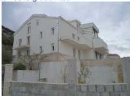
Zapadno pročelje; pogled jugozapad
