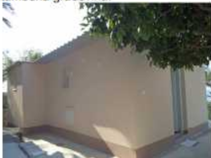
Sjeverno pročelje; pogled sjeverozapad
