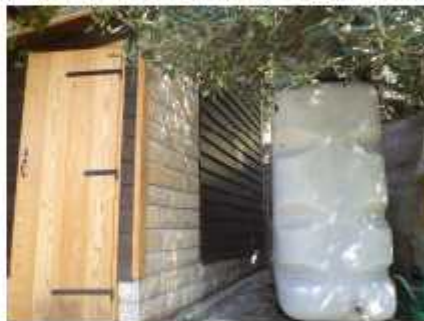
Istočno pročelje; pogled jugoistok
