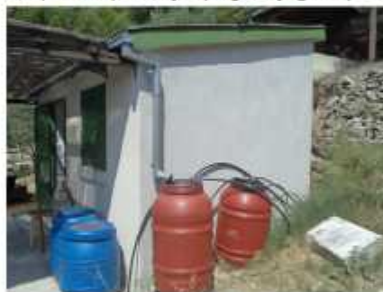
Istočno pročelje; pogled jugoistok
