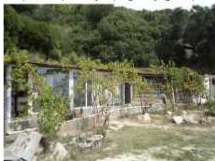
Južno pročelje; pogled jugozapad
