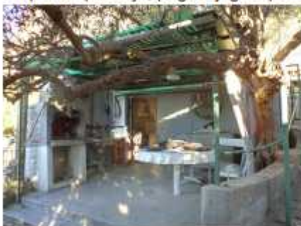
Južno pročelje; pogled jugoistok
