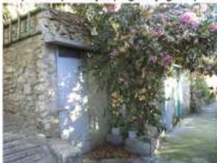
Južno pročelje; pogled jugozapad
