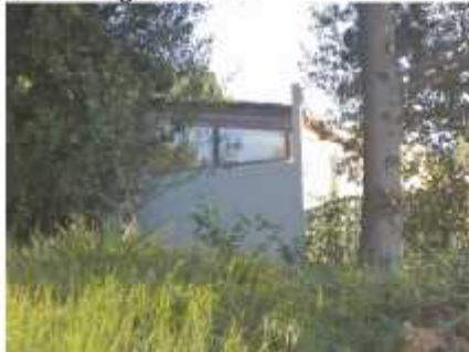
Zapadno pročelje; pogled jugozapad
