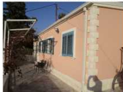
Južno pročelje; pogled jugoistok
