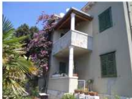
Zapadno pročelje; pogled jugozapad
