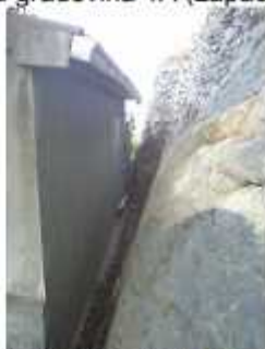
Sjeverno pročelje; pogled sjeveroistok
