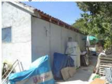
Sjeverno pročelje; pogled sjeveroistok
