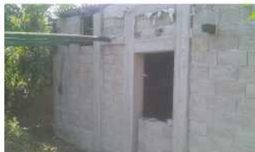
Južno pročelje Objekt A
