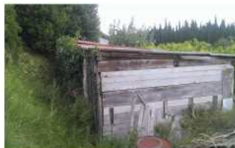
Pomoćni objekt; pogled sjeverozapad
