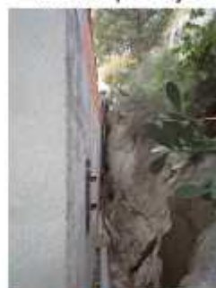
Sjeverno pročelje; pogled sjeveroistok
