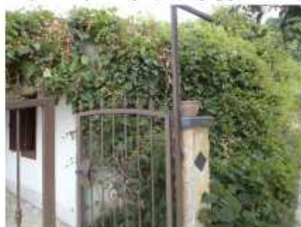
Istočno pročelje; pogled jugoistok
