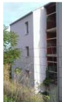
Sjeverno pročelje (zapadni dio)
