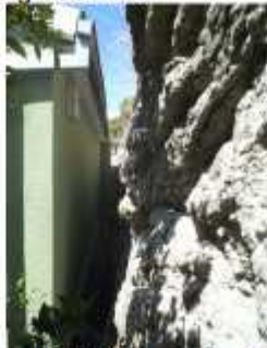
Sjeverno pročelje; pogled sjeveroistok
