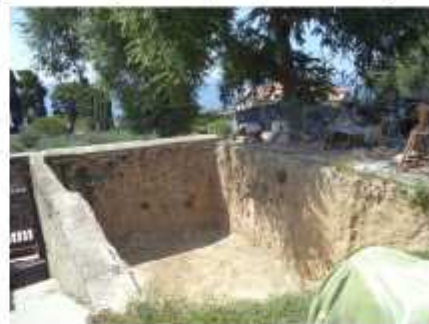
Građevna jama; pogled sjeveroistok
