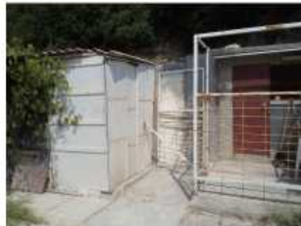
Istočno pročelje; pogled jugoistok
