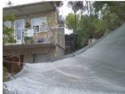
Istočno pročelje; pogled jugoistok
