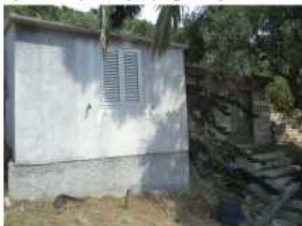
Južno pročelje; pogled jugozapad
