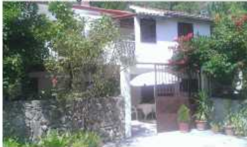
Istočno pročelje; pogled jugoistok
