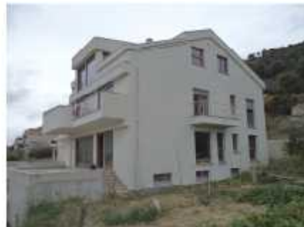
Istočno pročelje; pogled jugoistok
