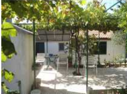
Sjeverno pročelje; zapadni dio građevine
