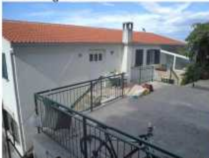
Sjeverno pročelje; pogled sjeveroistok
