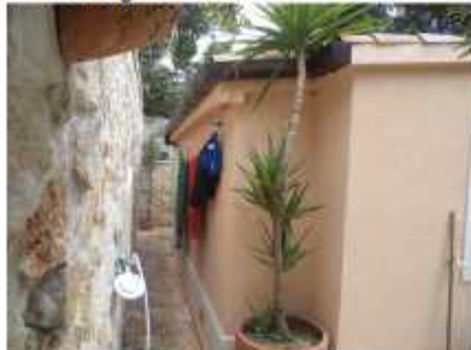
Sjeverno pročelje; pogled sjeverozapad
