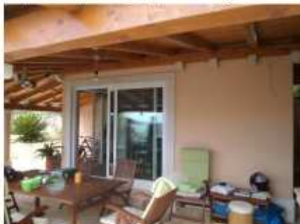
Južno pročelje; pogled jugoistok
