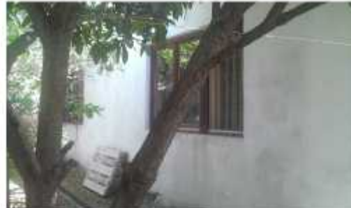
Zapadno pročelje; pogled jugozapad
