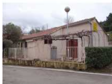
Sjeverno pročelje; pogled sjeverozapad
