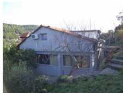
Zapadno pročelje; pogled jugozapad
