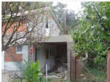
Južno pročelje; pogled jugozapad
