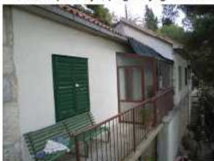
Južno pročelje; pogled jugozapad
