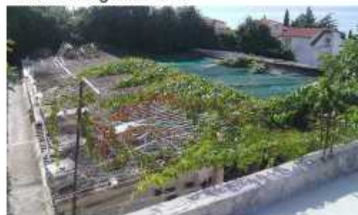
Pomoćni objekti; pogled sjeverozapad
