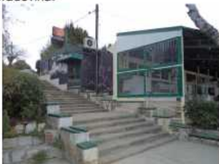
Zapadno pročelje; pogled jugozapad
