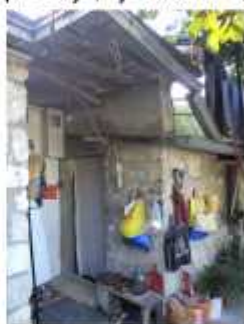
Zapadno pročelje; srednji dio građevine
