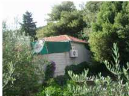
Istočno pročelje; pogled jugoistok
