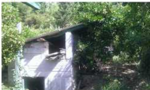
Južno i istočno pročelje Objekt B
