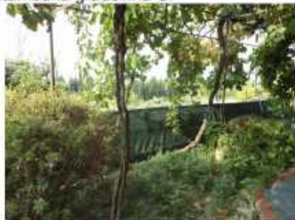
Sjeverno pročelje; pogled sjeveroistok
