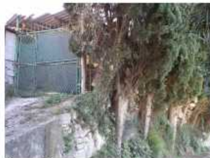
Garaža i ostava; pogled sjeverozapad
