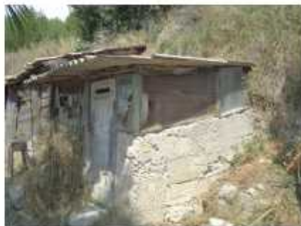
Istočno pročelje; pogled jugoistok
