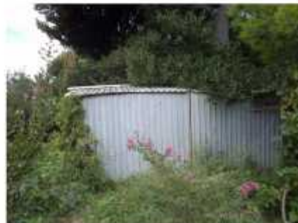
Pomoćna građevina 1; pogled istok
