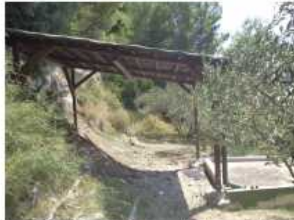
Nadstrešnica; pogled zapad
