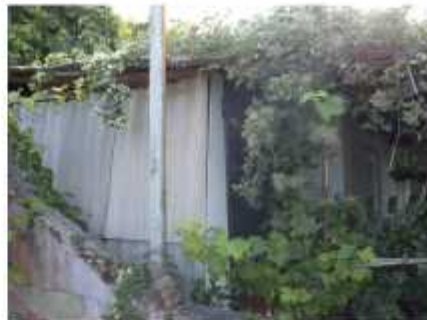
Zapadno pročelje; pogled jugozapad
