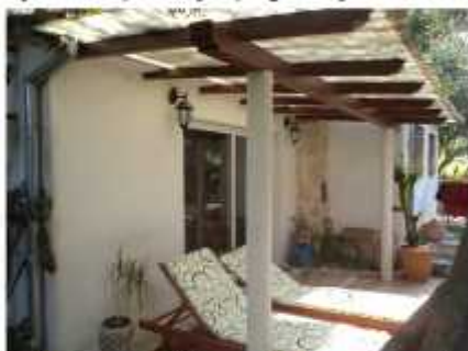
Južno pročelje; pogled jugozapad
