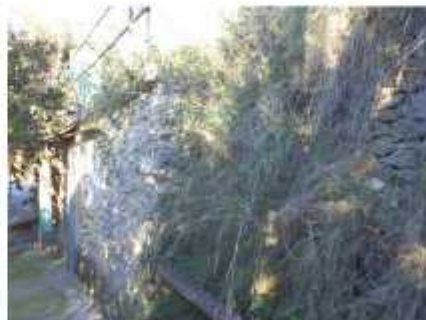
Južno pročelje; pogled jugoistok
