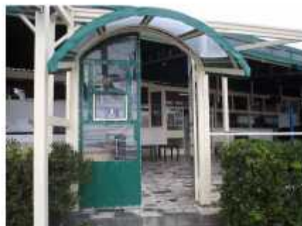
Južno pročelje; ulaz
