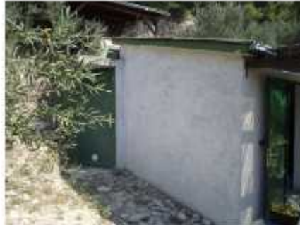
Zapadno pročelje; pogled jugozapad
