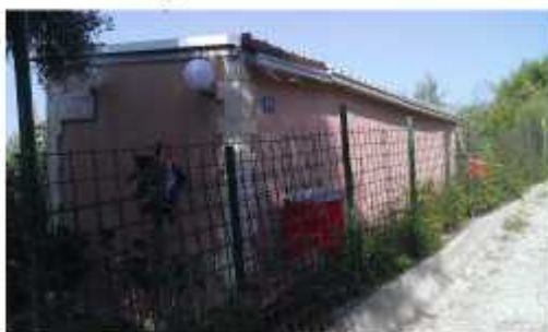
Istočno i sjeverno pročelje
