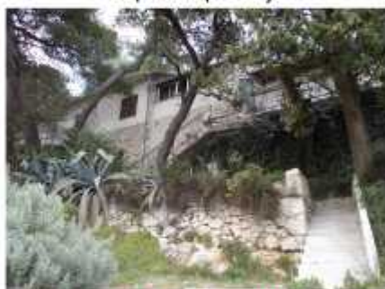
Južno pročelje; pogled jugoistok
