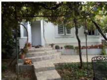
Južno pročelje – zapadni dio građevine
