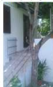
Jugoistočno pročelje; pogled jug
