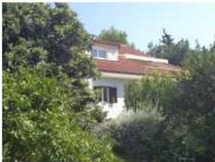
Južno pročelje; pogled jugozapad
