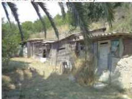
Južno pročelje; pogled jugoistok
