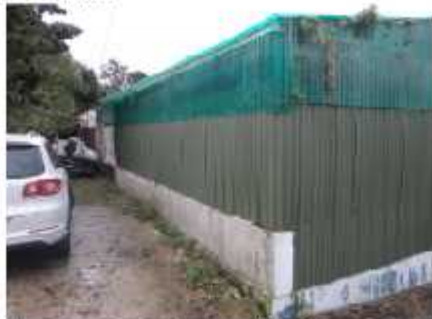
Sjeverno pročelje; pogled sjeverozapad
