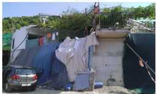
Sanirani zid terase
