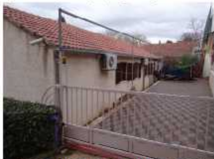
Južno pročelje; pogled jugozapad
