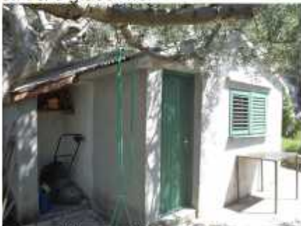
Spremište za alat; pogled jugozapad
