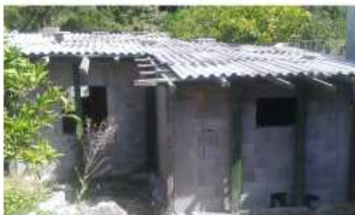
Istočno i sjeverno pročelje Objekt A
