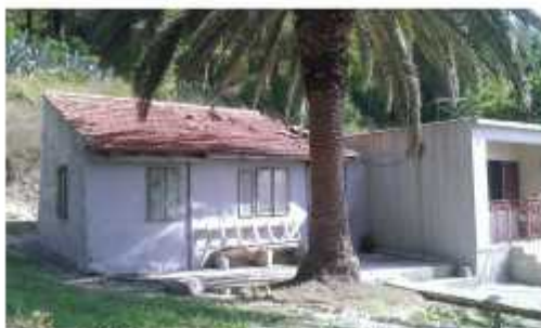
Južno pročelje; pogled jugozapad
