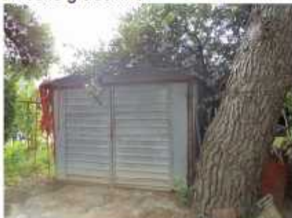
Pomoćna građevina 1; pogled sjever
