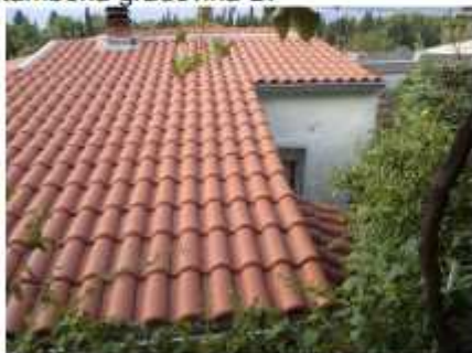
Sjeverno pročelje - zapadni dio građevine
