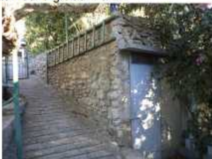
Zapadno pročelje; pogled jugozapad
