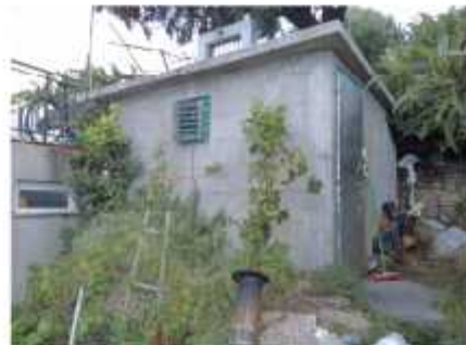
Pomoćna građevina 2; pogled jugoistok
