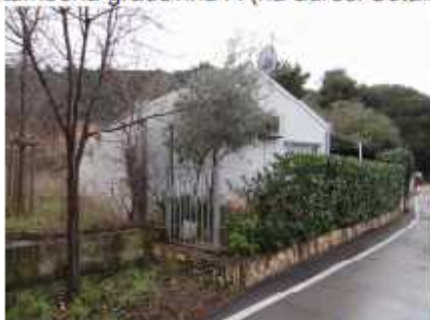
Sjeverno pročelje; pogled sjeveroistok
