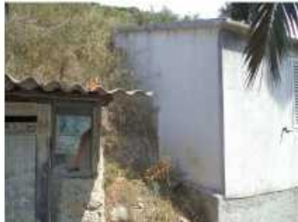
Zapadno pročelje; pogled jugozapad
