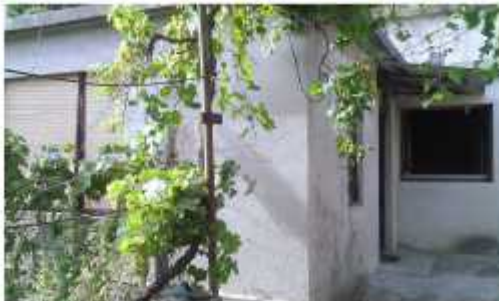
Južno pročelje; pogled jugoistok
