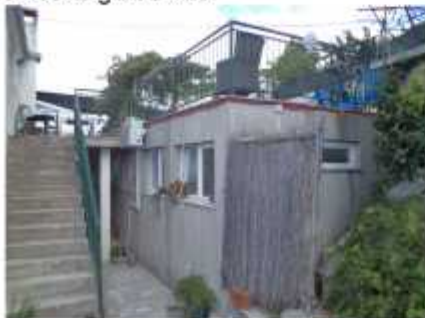
Pomoćna građevina 1; pogled jugoistok
