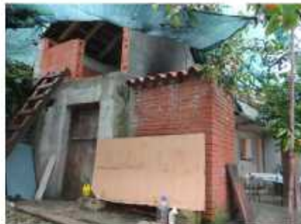
Sjeverno pročelje; pogled sjeverozapad
