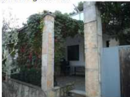
Sjeverno pročelje; pogled sjeverozapad
