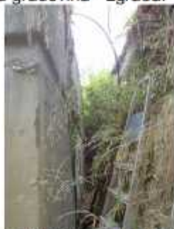
Sjeverno pročelje; pogled sjeveroistok
