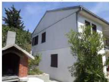
Zapadno pročelje; pogled jugozapad
