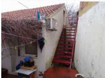
Južno pročelje; pogled jugozapad
