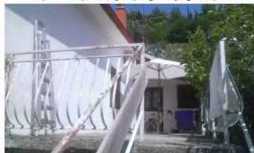
Istočno pročelje; pogled jugoistok
