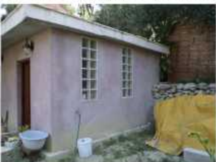
Južno pročelje; pogled jugozapad
