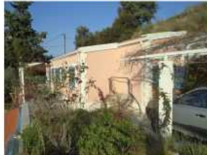
Istočno pročelje; pogled jugoistok
