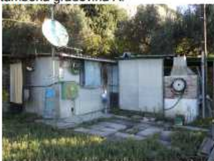
Zapadno pročelje; pogled jugozapad
