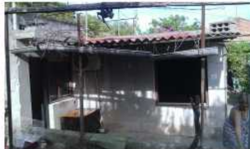
Zapadno pročelje; pogled jugozapad
