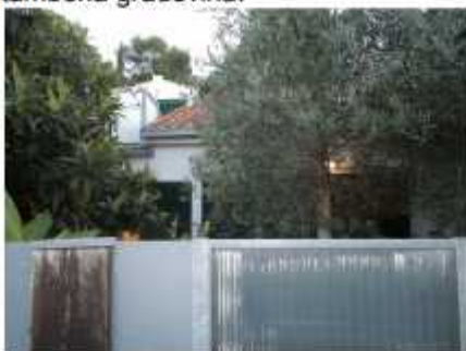
Sjeverno pročelje (jedan dio)
