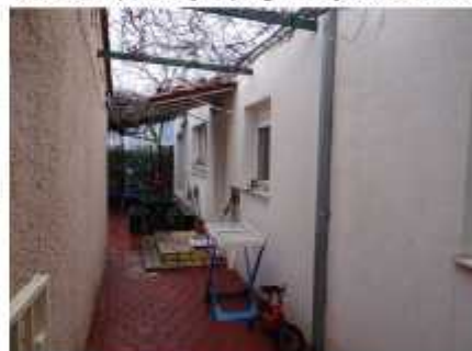
Zapadno pročelje; pogled jugozapad
