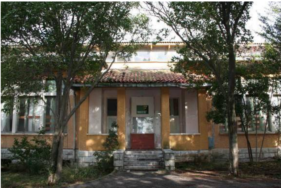
Slika 5. Glavni ulaz u zgradu iznad kojeg se vidi nadograđeno potkrovlje, današnje stanje
