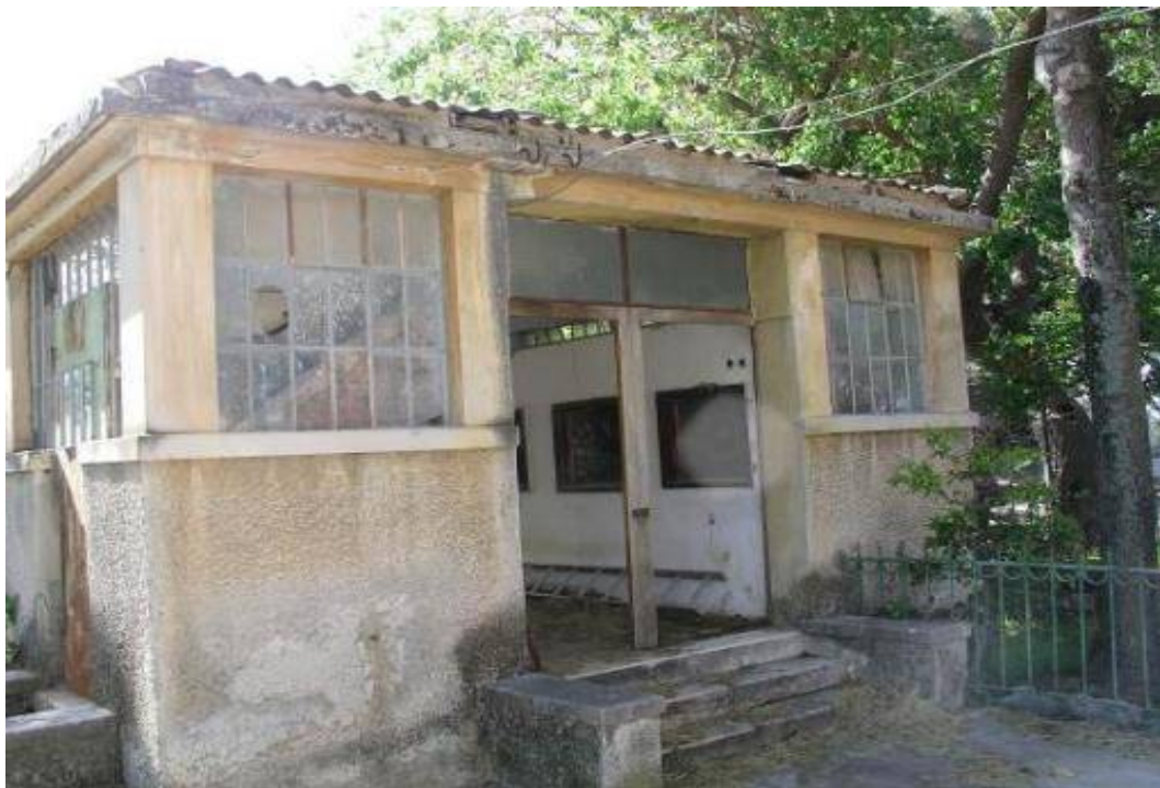
Slika 8. Zgrada akvarija prije rušenja
